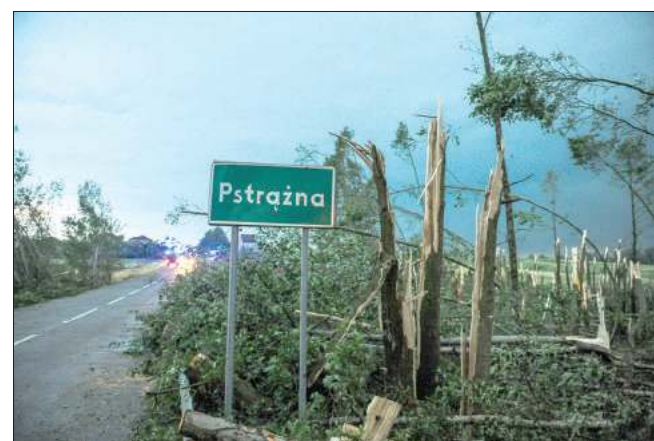
■ W Pstrążnej przeszła prawdziwa trąba powietrzna i potężny grad, uszkadzając wiele dachów, miejscowy kościół (uszkodzony dach, powybijane szyby) i łamiąc setki drzew.
