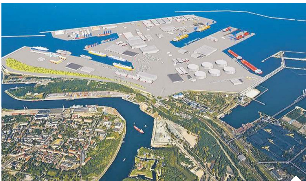
Budowa Portu Centralnego według „Strategii rozwoju portu Gdańsk do 2027 r.” jest priorytetowym zadaniem Zarządu Morskiego Portu Gdańsk | fot. mat. pras/d
