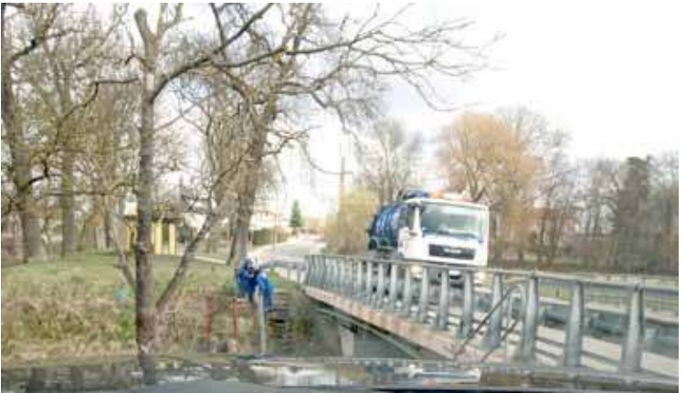
Wodociągi po zgłoszeniu zapchania zainterweniowały natychmiast udrażniając pompę
