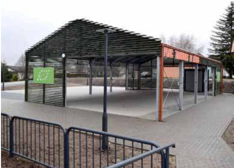
W ramach inwestycji wykonano również drogę dojazdową
