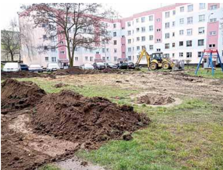
Rozpoczęła się budowa placu zabaw między ul. J. Przybosa i ul. S. Żeromskiego
