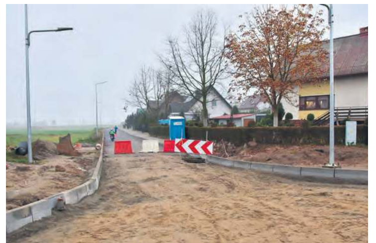
Prace na ul. Polnej: od skrzyżowania z Wiatrakową i Kwiatową do Słonecznej, mają zakończyć się w połowie listopada br.
