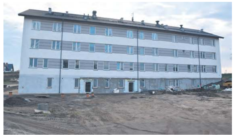
Widok na zakład opiekuńczo-leczniczy od strony ul. Wiejskiej.
