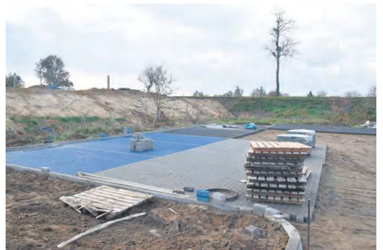
Sporo pozostało do zrobienia, jeśli chodzi o otoczenie obiektu. Obecnie trwa układanie kostki pod miejsca parkingowe.
