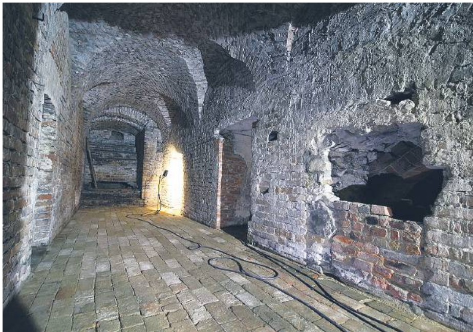
Klasztor Bazylianów na Górze Chełmskiej, piwnice po pracach remontowo-konserwatorskich, 2022 r.
