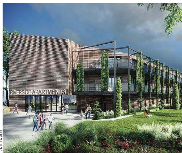
Przy ulicy Warszawskiej ma powstać 96 apartamentów, trzygwiazdkowy hotel na około 100 pokoi oraz 14 miejsc do cumowania wraz z infrastrukturą
