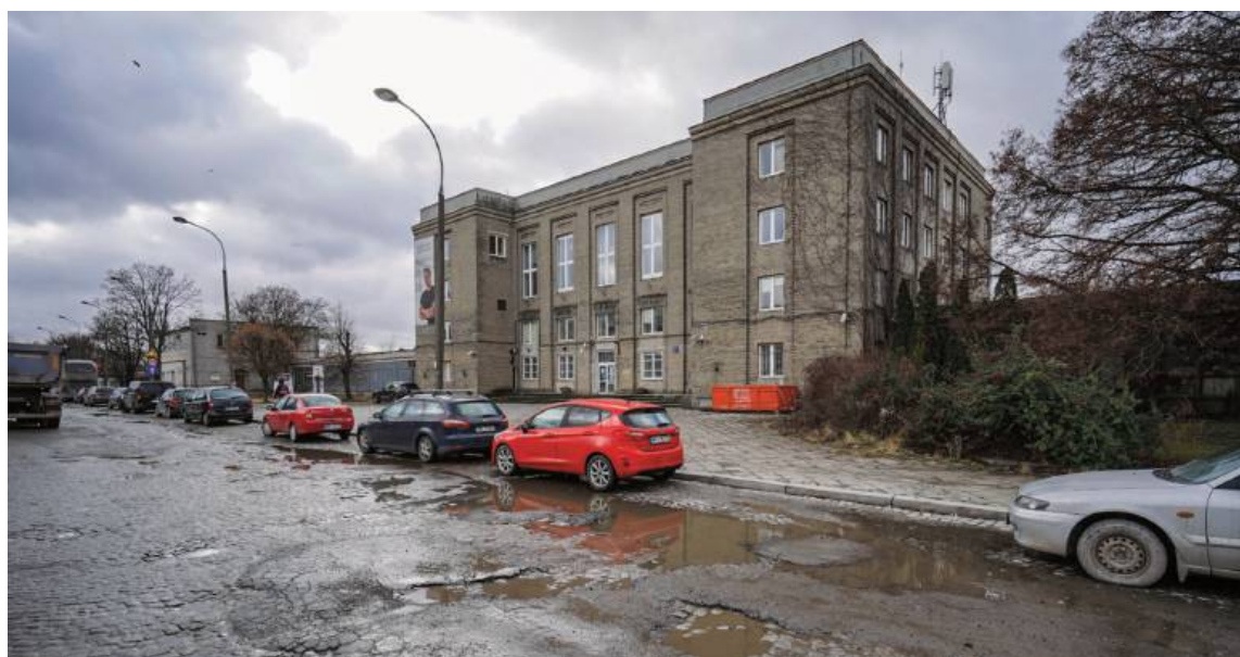
W związku z remontem ZDM apeluje o przeparkowanie aut w miejscach, gdzie rozpoczną się prace | fot. ZDM/d
