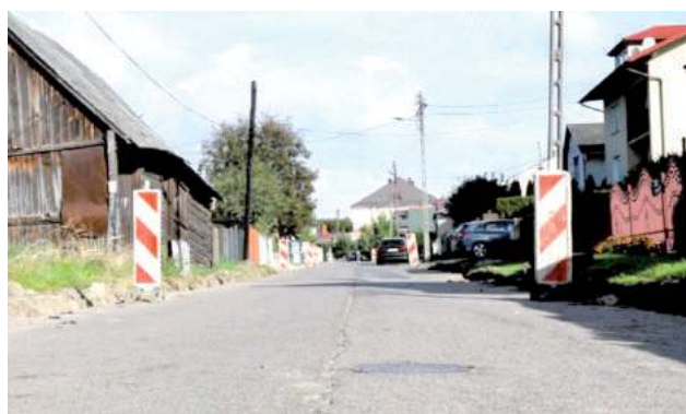
Remont ulicy Orzechowej we Frampolu już trwa
