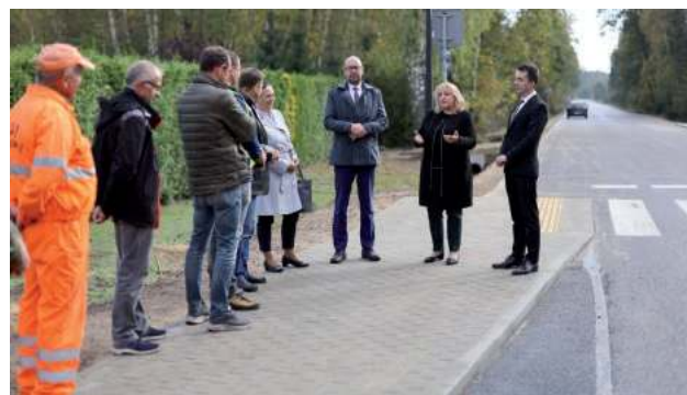
Pierwszy etap przebudowy drogi powiatowej Księżpol-Harasiuki powoli się kończy
