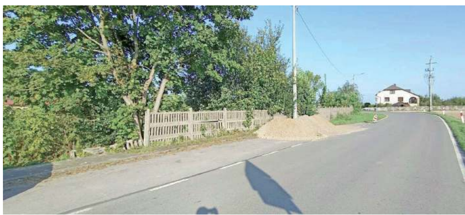
Tak wyglądał płot przed rozbiórką. Zdjęcie nadesłane przez UG Biszcza
