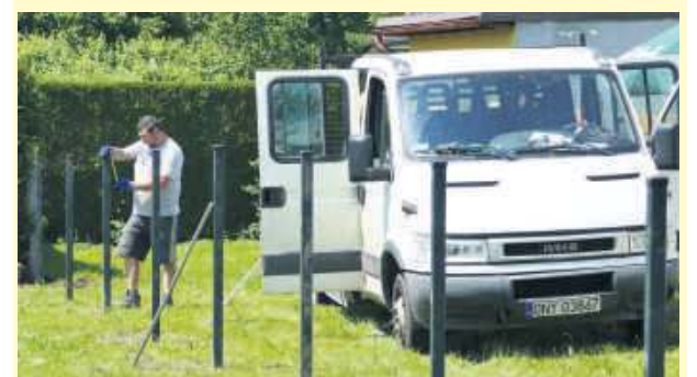
Ogrodzenie przy remizie w Przewornie stawia na zlecenie gminy firma z Pakosławic
