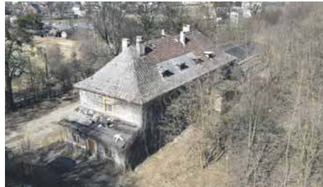
We wrześniu 1994 r. przejechał tędy ostatni pociąg pasażerski, a w maju 1999 r. towarowy. Od tego czasu dworzec popada w ruinę
