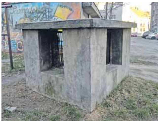
Wylot wyjścia awaryjnego ze schronu znajdującego się pod blokiem przy ul. Bończyka. Zapewnia możliwość wydostania się z ukrycia, gdyby na skutek np. bombardowania zawalił się korytarz piwniczny
