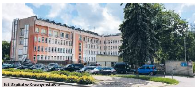
fot. Szpital w Krasnymstawie
