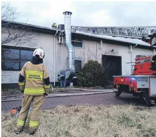
Strażacy pracujący na dachu hali
