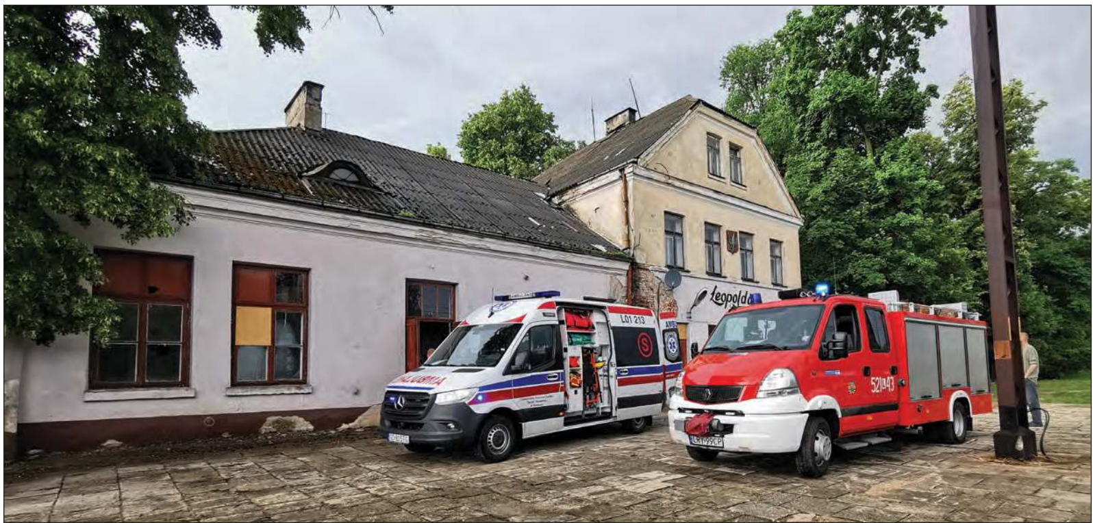
Prokuratura zleciła przeprowadzenie sekcji zwłok 67-latki. Trwa postępowanie wyjaśniające. Po wypadku na dworcu pojawili się także przedstawiciele PKP oraz inspektor budowlany. Uznano, że budynek jest w bardzo złym stanie i nadaje się tylko do rozbiórki
