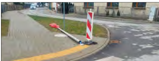
Lampa została uszkodzona przez złodzieja.
