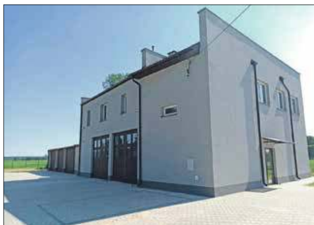
W ramach rewitalizacji kompleksowo zmodernizowano budynek po byłej Spółdzielni Kółek Rolniczych w Tucznej
