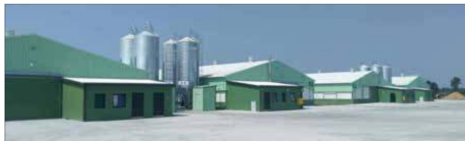
Nowym projektem spółki są „Zielone Fermi”. To obiekty hodowlane dla brojlerów ras mięsnych przyjazne dla środowiska i wykonane w energooszczędnej technologii
