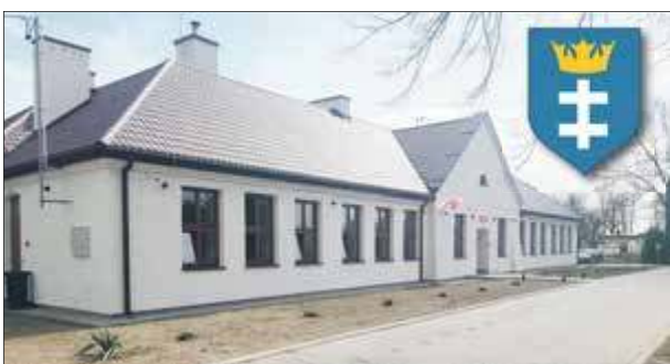
Centrum Opiekuńczo-Mieszkalne to jedna z najważniejszych inwestycji w obecnej kadencji wójta Łomaz Jerzego Czyżewskiego
