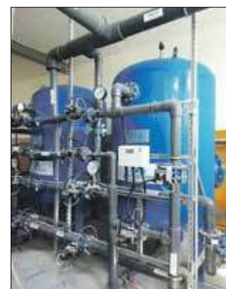
Modernizacja ujęcia wody w Tucznę to inwestycja priorytetowa dla wójty Litwiniuka
