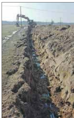
Gmina postawiła sobie za cel rozbudowę sieci wodno-kanalizacyjnej i go zrealizowała
