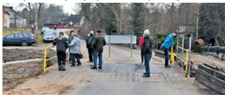
Na moście w Zawadzie zostanie ułożona dodatkowa konstrukcja, która sprawi, że mieszkańcy będą mogli bezpiecznie przeprawać się przez rzekę.
