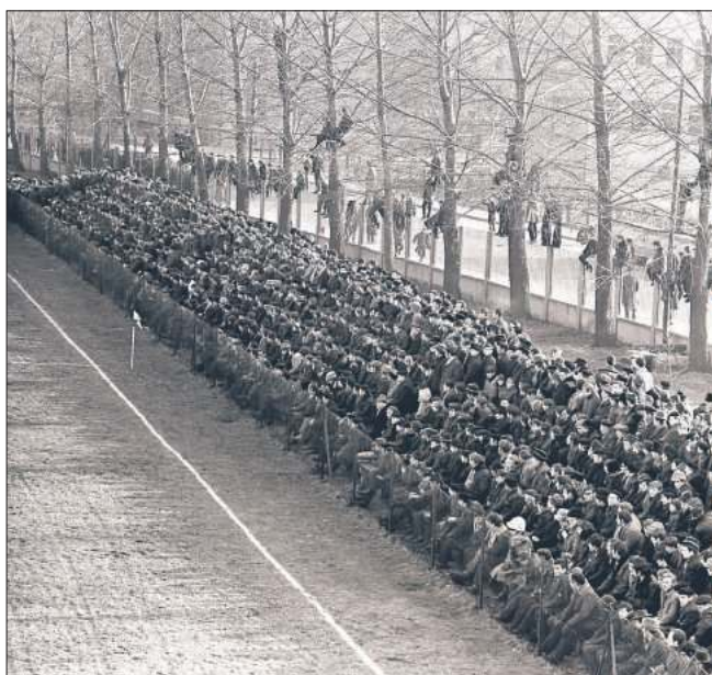
Stadion Stali Mielec przed rozbudową.
