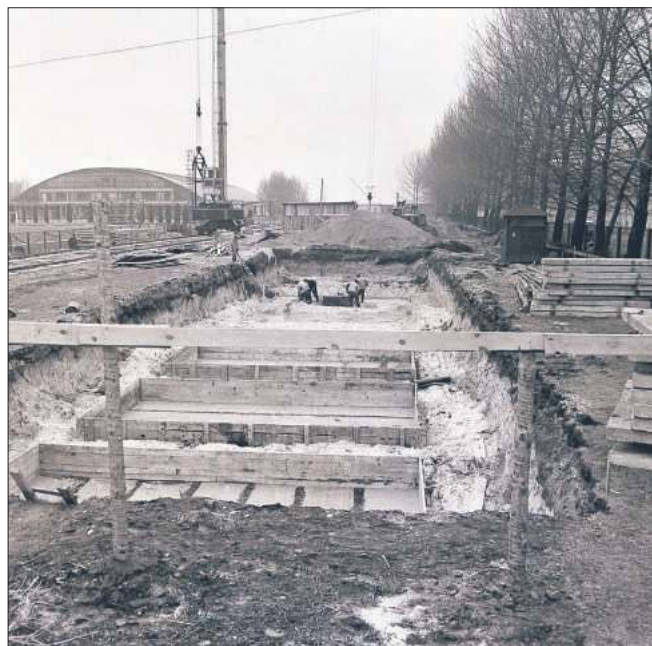
Zdjęcie placu budowy od strony ulicy Solskiego. W tle „Hangar Arena”.
