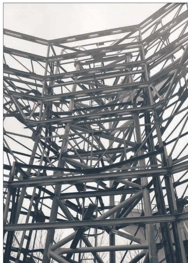
Jupiter w trakcie montażu.
