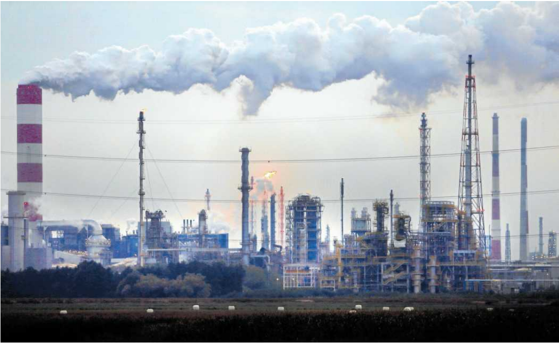
• Orlen zapowiadał, że dzięki nowej instalacji wykorzystującej licencję koncernu Shell będzie można wytwarzać więcej paliw z przerobu ropy naftowej FOT. TOMASZ NIEŚUCHOWSKI / AGENCJA WYBORCZA.PL
