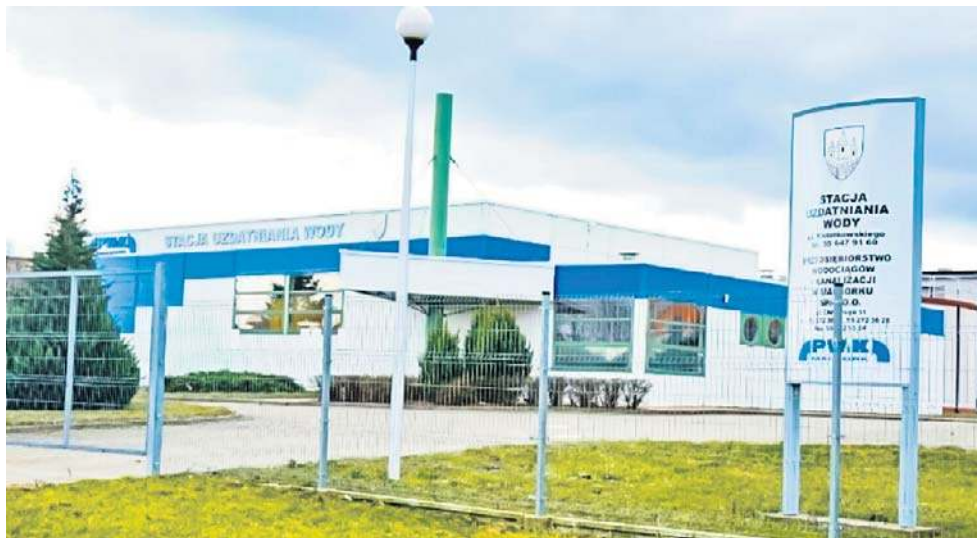
Stacja Uzdatniania Wody w Malborku z zewnątrz
