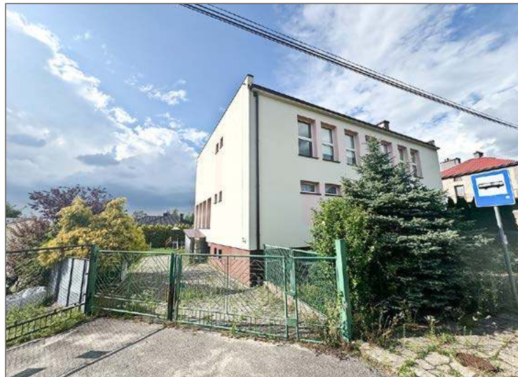
Plac znajduje się za budynkiem, w którym działała kiedyś SP nr 8.
