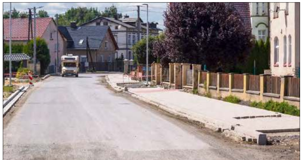
Na drodze układane są nowe krawężniki i chodniki.
