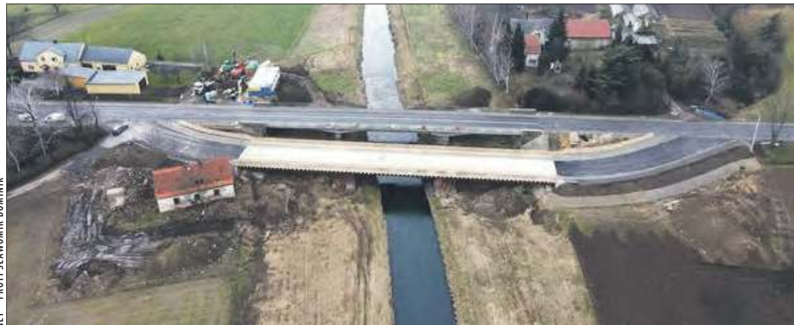
Niecodzienny widok dwóch mostów
