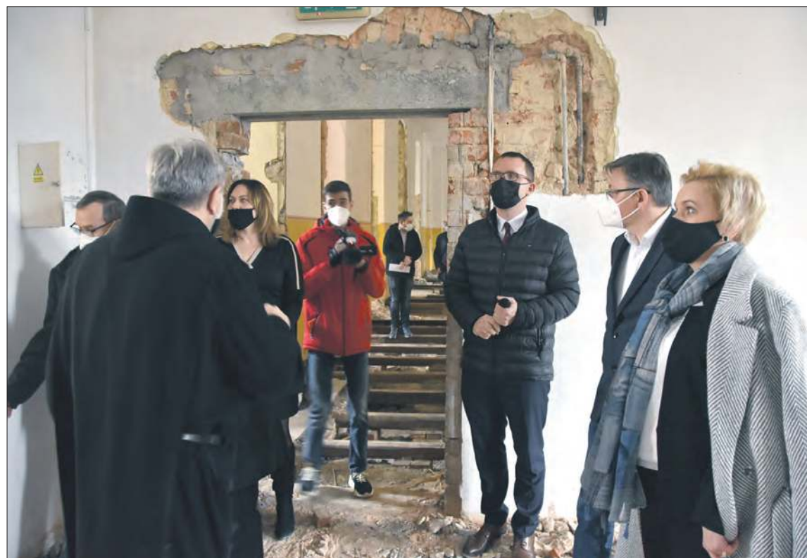
Prace remontowe w obiekcie z przeznaczeniem na organizację warsztatów
