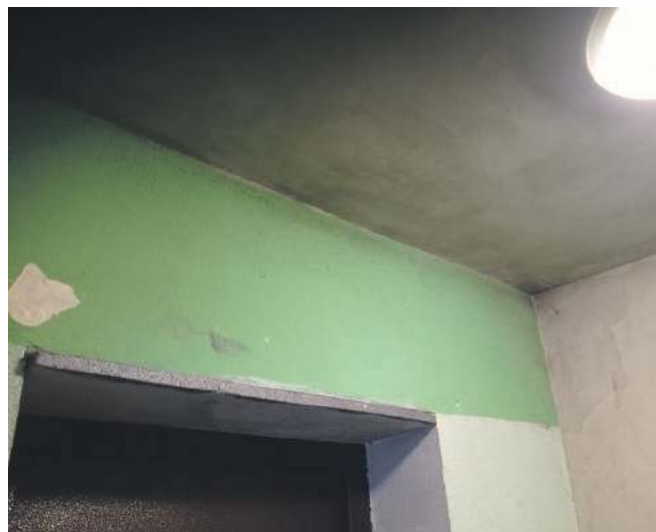
Sufit i ściany w przedpokoju
