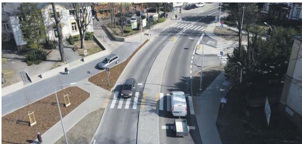
Centrum Obornik Śląskich po przebudowie
