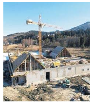
Budynek osiągnął już stan surowy
