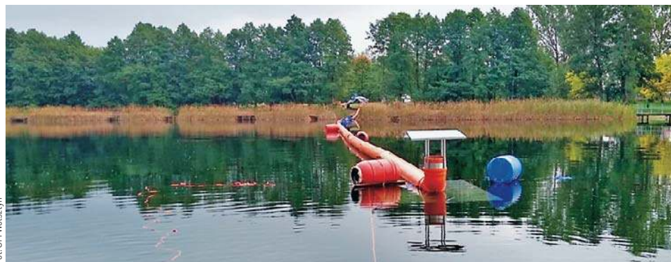
Zatapianie jednego rurociągu
