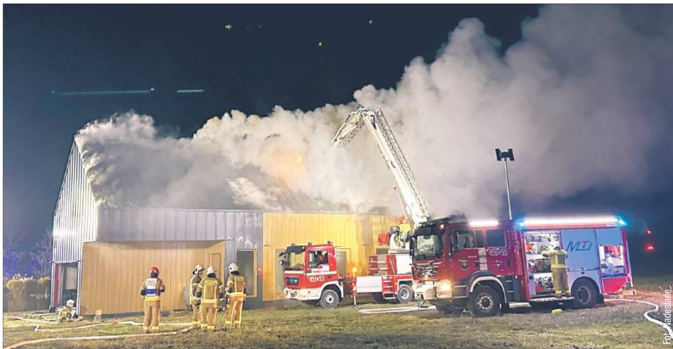
Elewacja była pokryta blachą na rąbek stojący.
