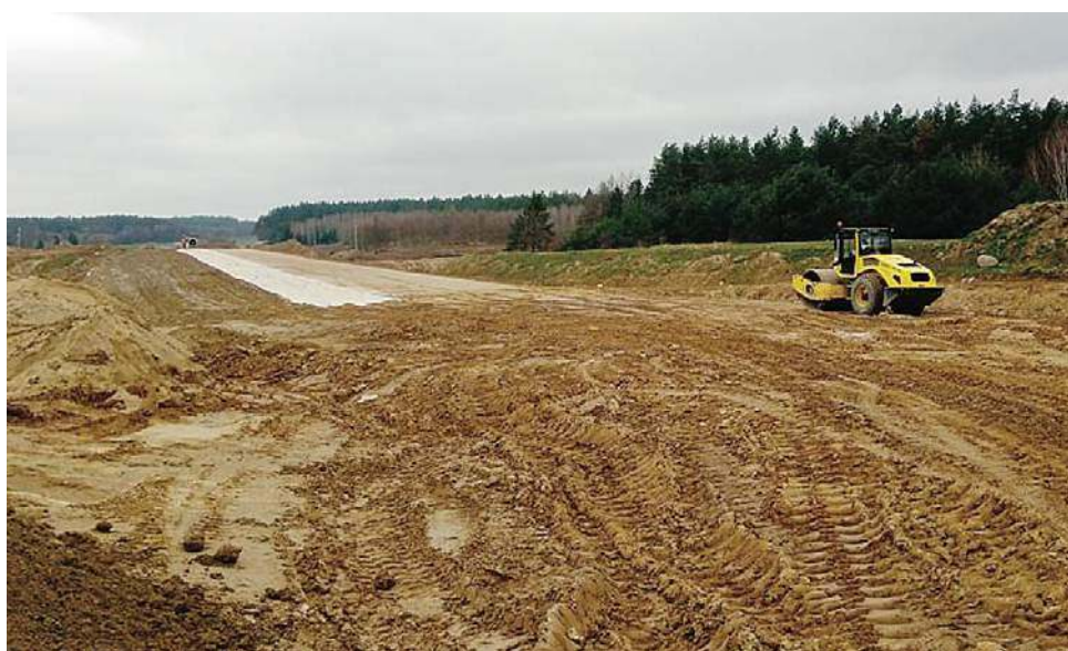
Prace trwają w okolicy Wirwajd koło Ostródy
