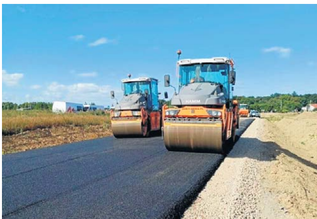
Budowa drogi z Redzikowa do Jezierzyc
