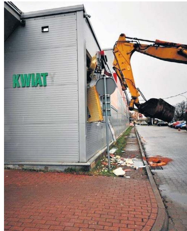
Złodzieje chcieli dostać się do kantoru za tą ścianą....
