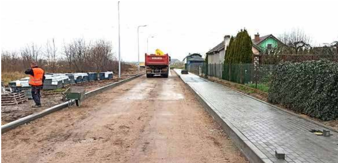
Wykonawca układa też warstwy podbudowy pod jezdnię
