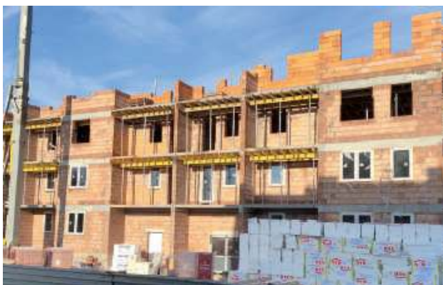
Tak w ubiegły piątek wyglądał wznoszony budynek komunalny w Terespolu
