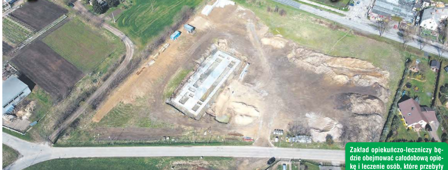
Plac budowy przy ulicy Wiejskiej, Sępoleńskiej i Mickiewicza.
