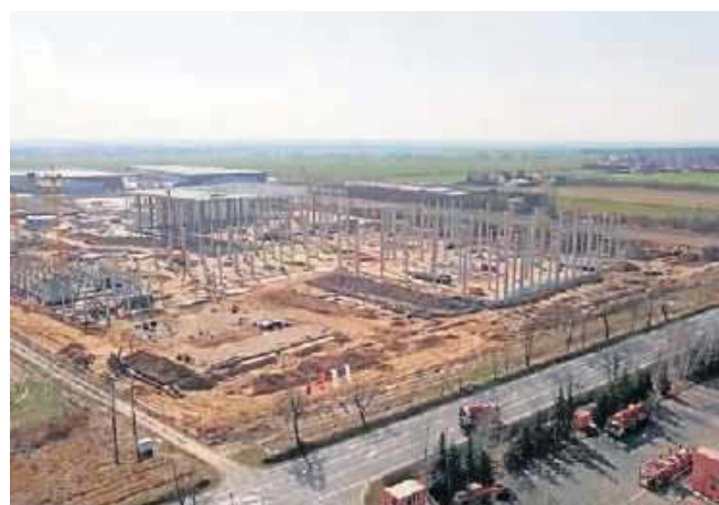
Wróblowice. Trwa budowa fabryki chemii gospodarczej i higieny osobistej Persan. Ma zatrudnić 1000 osób
