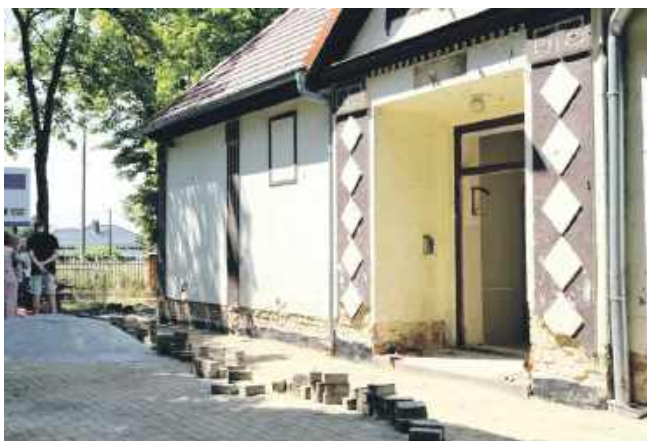
Przedszkole w trakcie remontu
