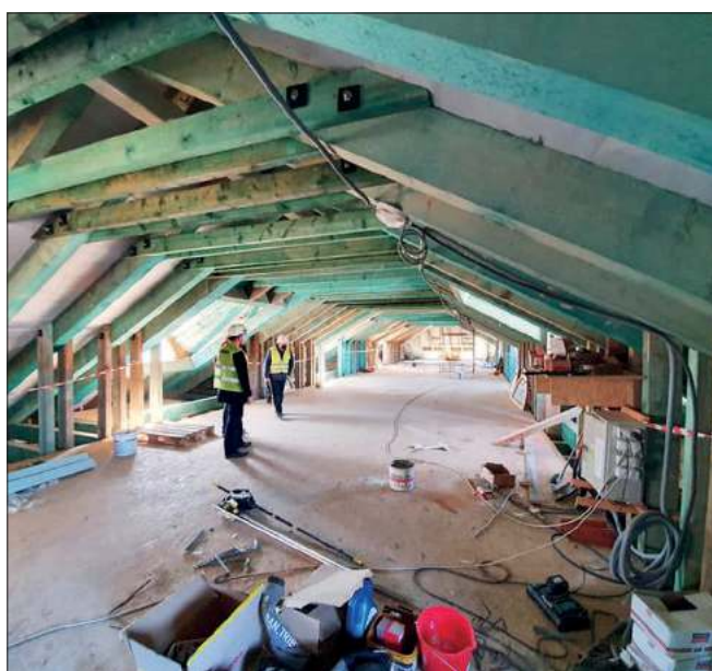
Belki pochodziły z m.in. usuniętej więzby dachowej. Jak tłumaczy miasto, nie mają charakteru zabytkowego i są traktowane jak odpad poremontowy
