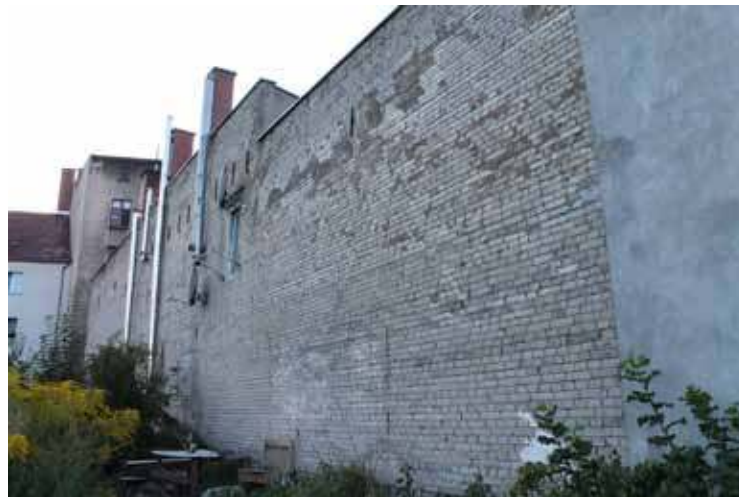
Ściana bloku przy Wojska Polskiego 91 A nie zostanie ocieplona, ponieważ TBS nie planuje już dalszych remontów tego budynku
