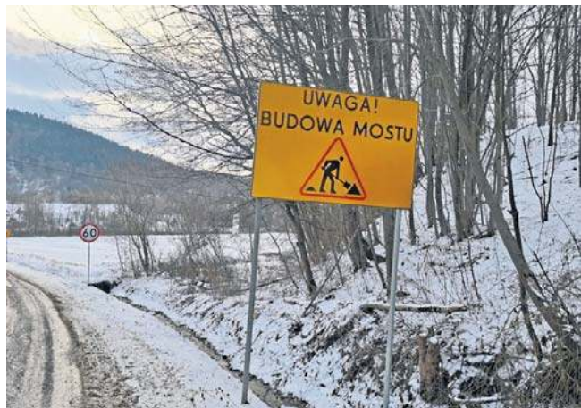
W Szymbarku trwa budowa mostu na Ropie na drodze w kierunku przysiółka Wółka. Prace szybko postępują
