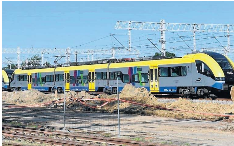
W tym miejscu powstanie zaplecze techniczne dla Kolei Małopolskich przy dworcu w Oświęcimiu
