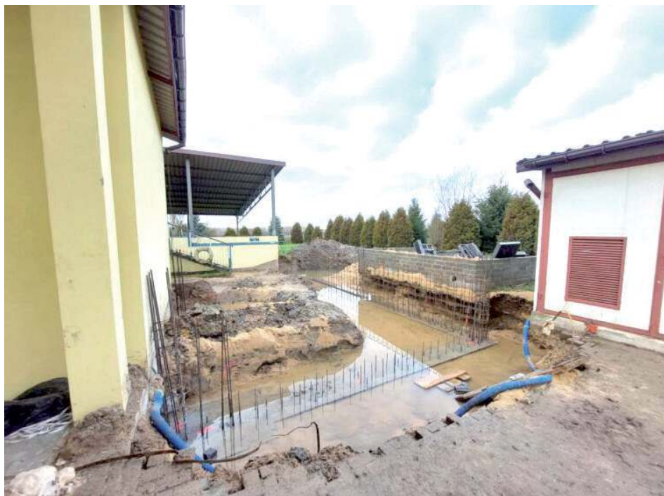
Do 5 listopada 2023 roku, mieszkańcy Frampola dostaną odnowioną oczyszczalnię
