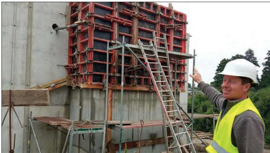
- Mamy zabetonowane ściany zbiornika, czyli wielofunkcyjnego reaktora. Teraz musimy wykonać pomost roboczy, a później będziemy robić izolację wewnętrzną i zewnętrzną obiektu - wyjaśnia Jerzy Szyszka, kierownik robót z przedsiębiorstwa „Aqua” Tomaszowice
