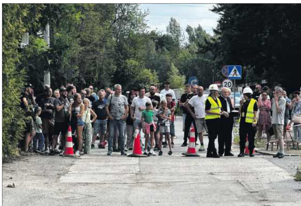
■ Wyburzenie obserwowali mieszkańcy i byli pracownicy kopalni
