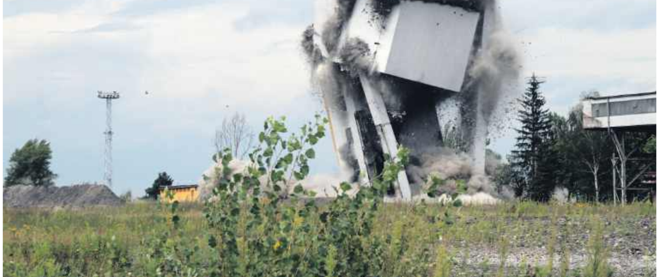
■ Wyburzenie wieży szybowej Jas II po byłej KWK Jas-Mos. 19.08.2026 r.
