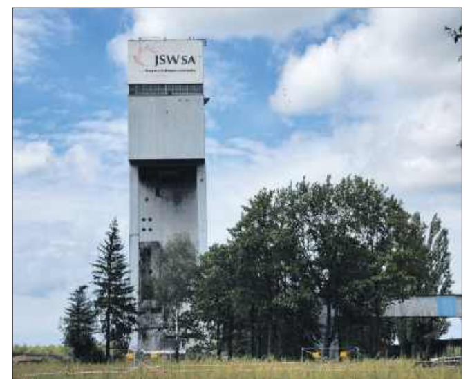
■ Wieża szybowa na kilka minut przed detonacją
