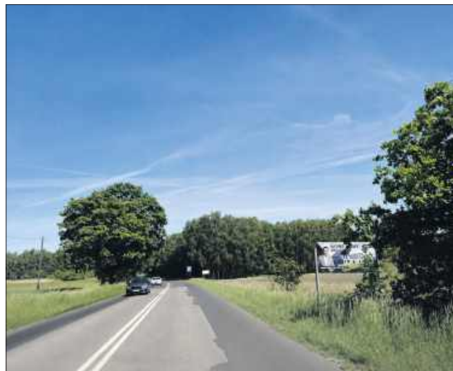
■ Od poniedziałku utrudnienia na trasie Kornowac – Rydułtowy. Ruszyła przebudowa DW 935
