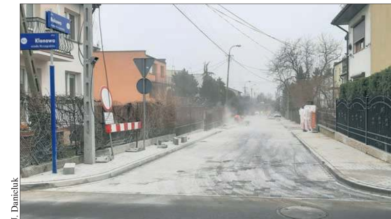
Trwa przebudowa ulicy Bukowej
