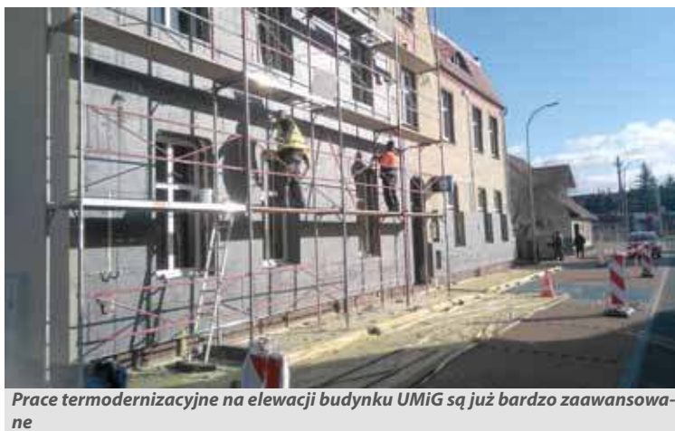
Prace termomodernizacyjne na elewacji budynku UMiG są już bardzo zaawansowane
