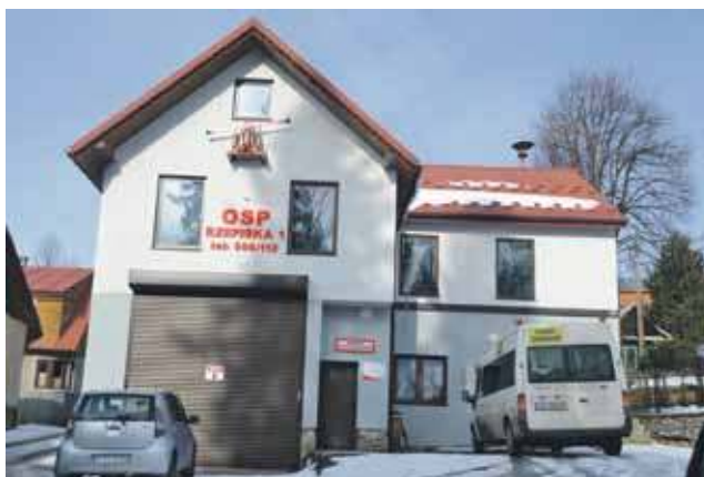
Sołtyska wsi apeluje do gminy o budowę centralnego ogrzewania w remizie.
