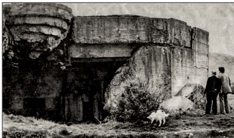
Jeden z wysadzonych schronów-stanowisk bojowych baterii Lindemann (już bez armaty) typu S 262 w pierwszych latach powojennych.
