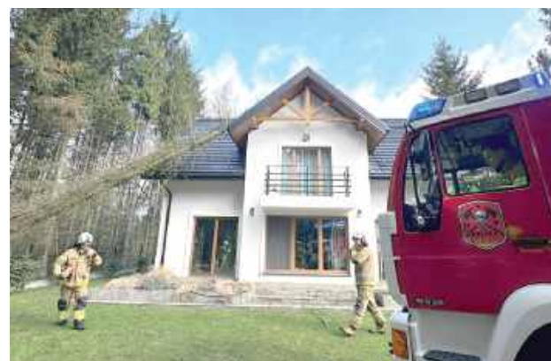
Przewrócone drzewo na budynek mieszkalny
