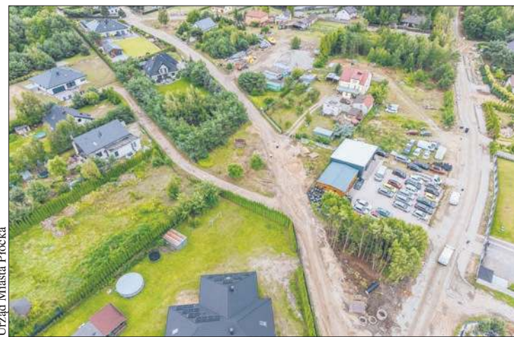
Trwa przebudowa ulicy Browarnej
