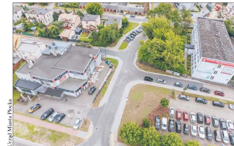
Zakończyła się budowa ulic Strzeleckiej i Powstańców Styczniowych
