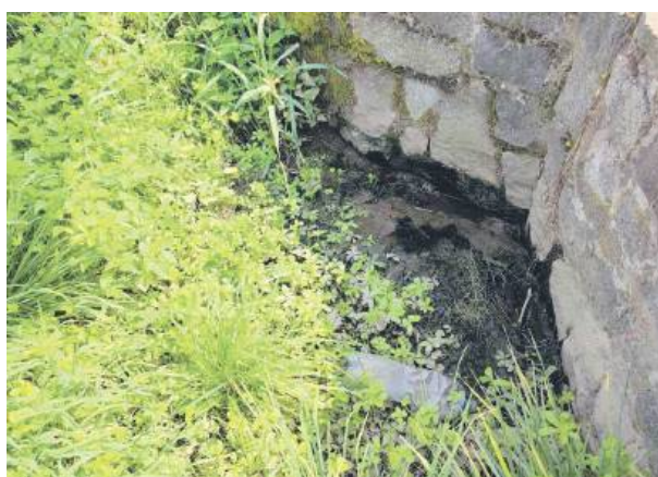
Pod tym namuliskiem znajduje się przepust. Jest to mostek przy drodze w kierunku Kazanowa
