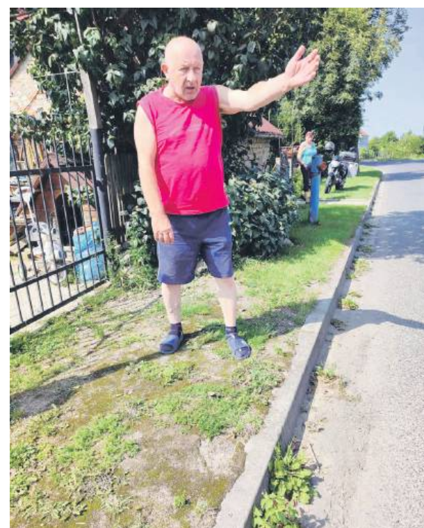
Jan Zasimowicz stoi obok krawężnika, który miał być zaporą przeciwko wodzie, spływającej z drogi na jego posesję
