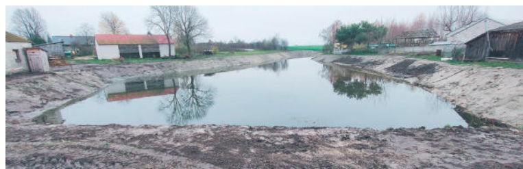
Staw w Dzierzbach Szlacheckich w listopadzie, gdy prace renowacyjne jeszcze trwały.
