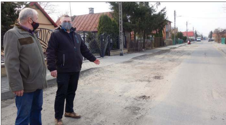
✚ Jerzy Jakubik i Robert Bąbel pokazują ubytki w drodze. - Jej stan jest kiepski i poruszamy się tylko jednym pasem. Po deszczach trzeba uważać na duże doły, bo można urwać koło - mówi pan Robert
