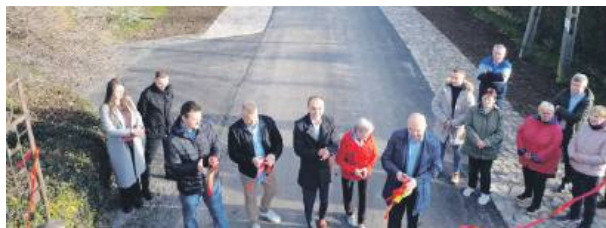
Przebudowany odcinek drogi liczy 135 metrów
