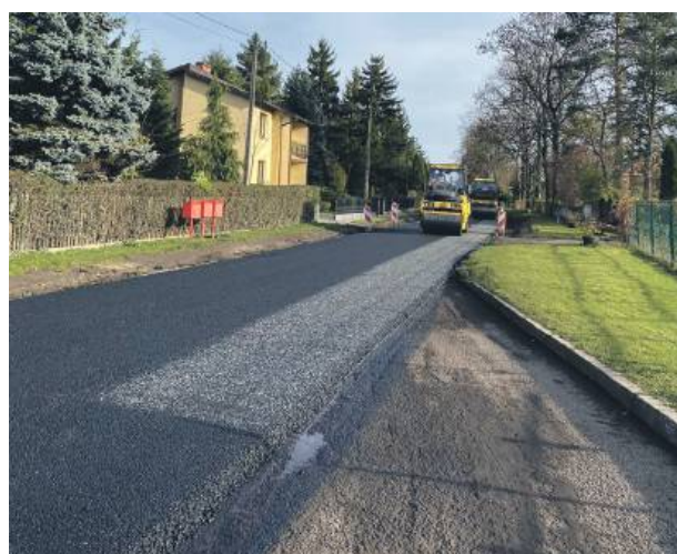
Remont drogi powiatowej w Trzeźni
